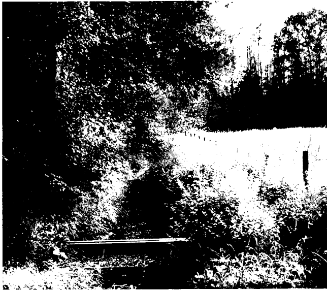
FIGUUR 2. De afwateringssloot aan de noordkant van de Venkoelen. Op een aantal plaatsen zijn in het gebied stuwen aangebracht om de waterhuishouding te kunnen regelen (foto: F. Coolen).
